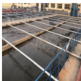
可提升曝气管
