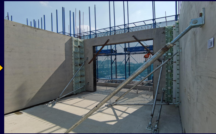
8、竖向模板安装
