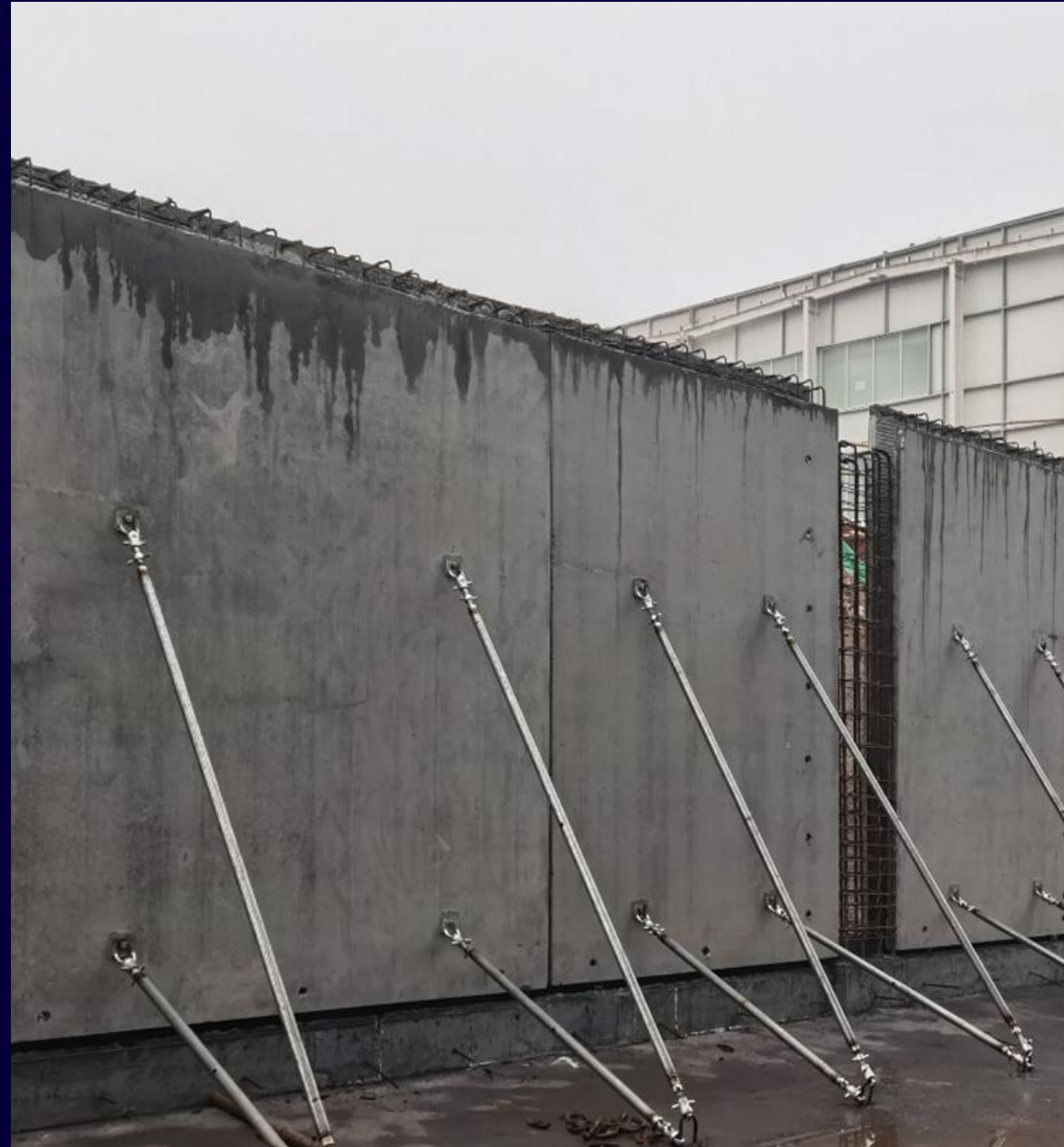
地下室外墙构件安装
