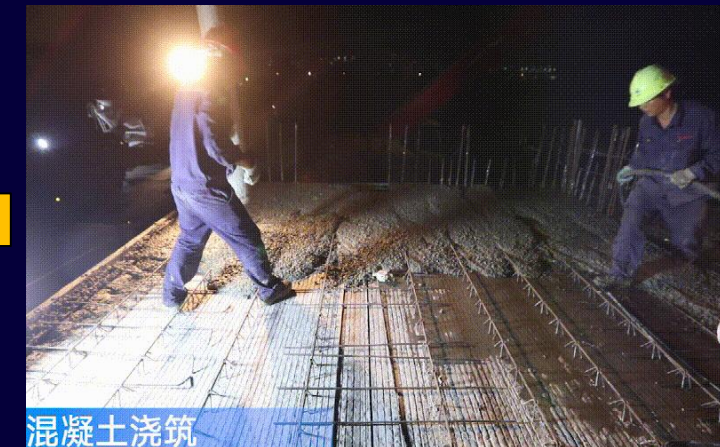
11、混凝土浇筑
